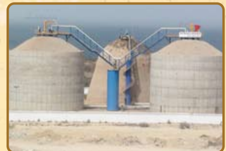
Fin des travaux
