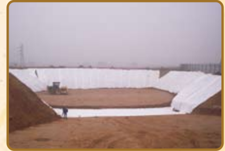
Etape 3 : Compactage : Pose de bidime antipollution
