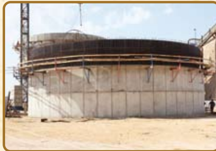
Etape 5 : Construction des sarcophages béton
