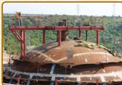
Etape 8 : Achèvement du montage par soudage
