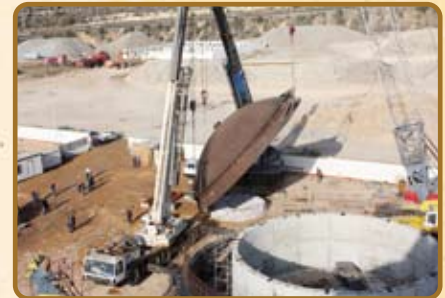
Etape 6 : Pose calotte inférieure sur jupe en béton
