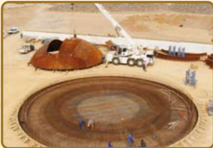
Etape 4 : Pose de dalle, ferrailage principal
