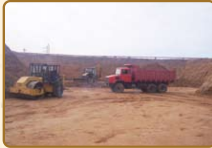
Etape 2 : Compactage : Reconstitution du sol
